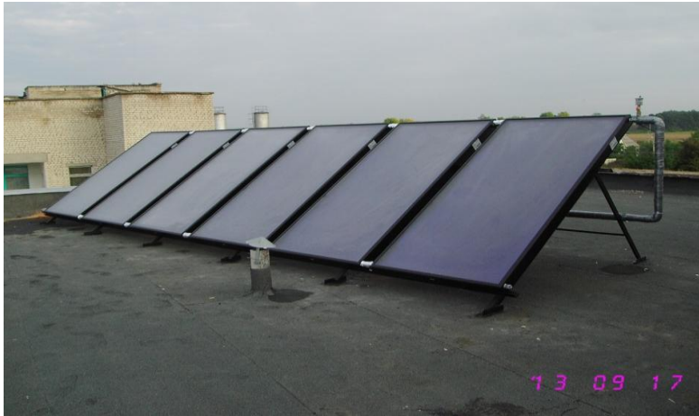
г. Гайворонка, реконструкция горячего водоснабжения больницы
