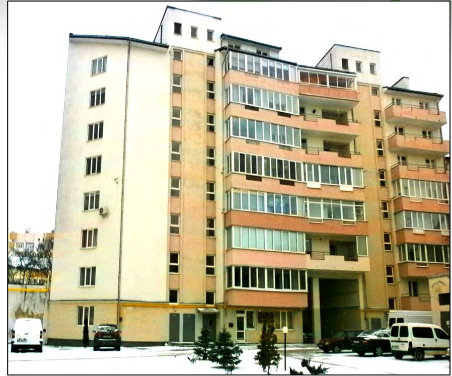
Фотография утепленного фасада дома по ул. Головацкого, 23-г (Львов)
