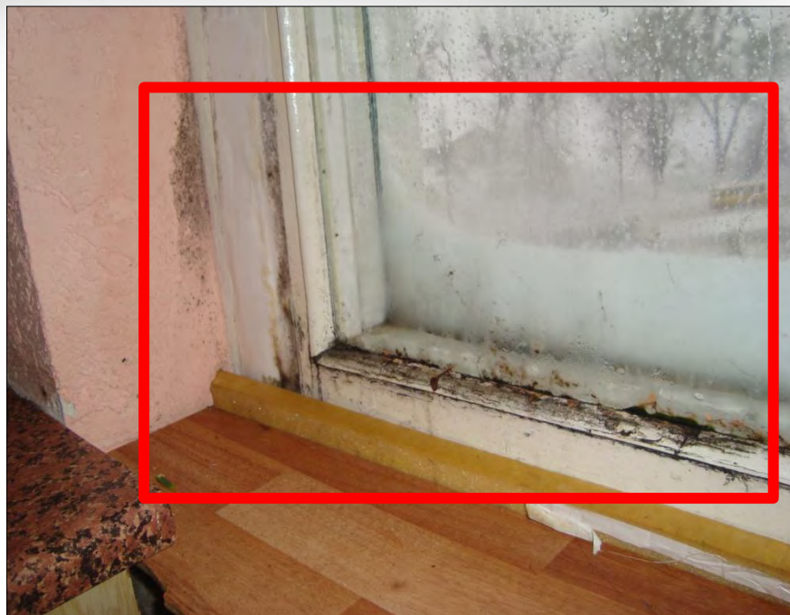
Конденсация избыточной влаги и колонии плесневых грибов на окне жилой квартиры
