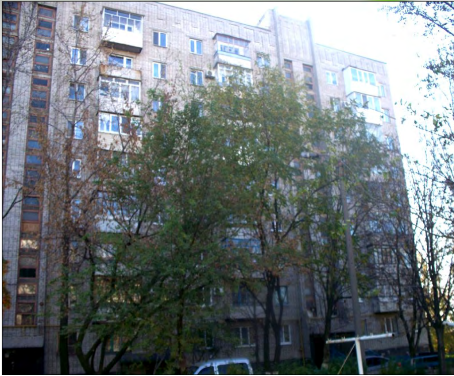
Фотография фактического состояния фасада дома по ул. Стефанова, 46 (Запорожье)
