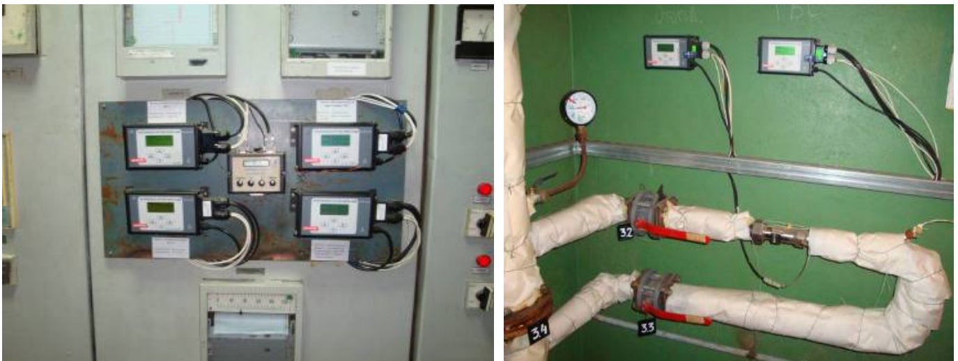
Малюнок 1.2.2. Установлення СВТУ-10М Ду 32 мм у тепловпунктах житлових будинків м. Запоріжжя
