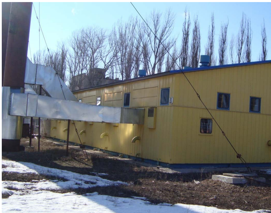
Котельня смт Ківшарівка
