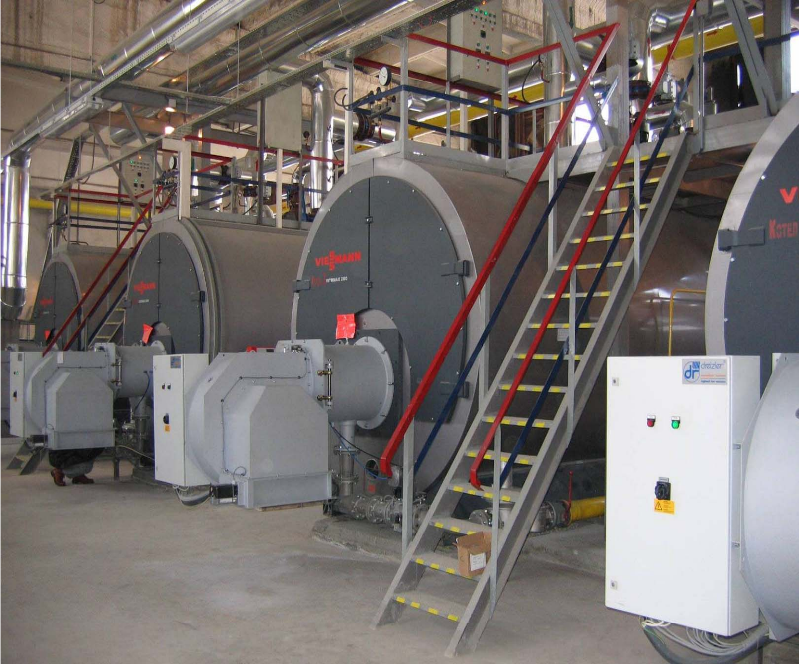
Районна котельня (м.Львів): 4 x Vitomax 200 LW 9.300 кВт
