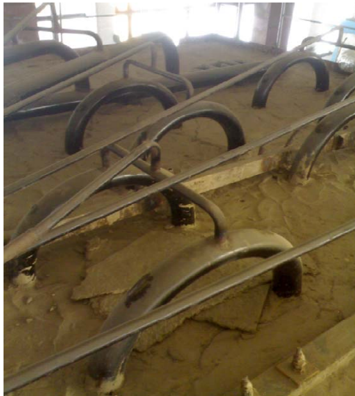
Мал. 7.13. Вид котлу ТВГ-8М зверху. Виконання перепускних трубопроводів трубного контуру котлу, що відрізняється від типового.
