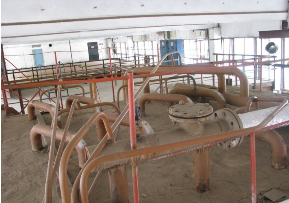
Мал. 7.12. Вид котлу ТВГ-8М зверху. Типове виконання перепускних трубопроводів трубного контуру котлу.
